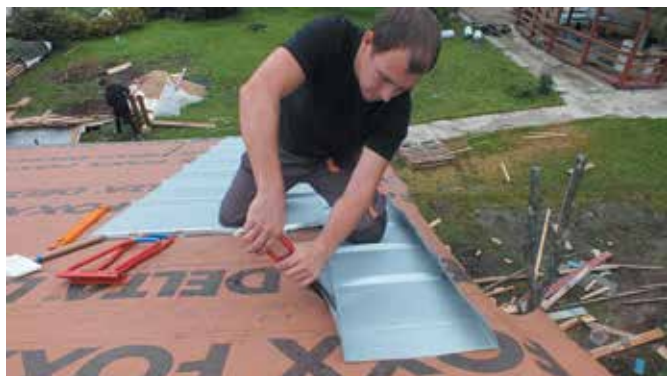
Отбортовка боковых частей картины конвертными клещами
