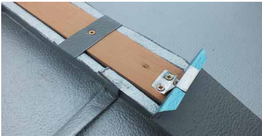
Узел крепления декоративных рядовых реечных элементов
