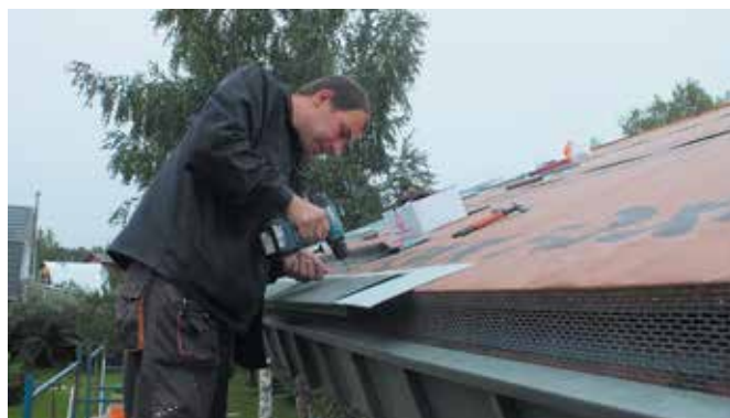
Установка на карнизном свесе крыши фальш- и карнизной планок
