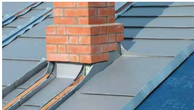
Обход дымоходной трубы в технике реечного фальца
