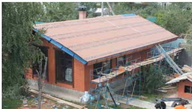
Укладка разделительного слоя в виде диффузионной мембраны
