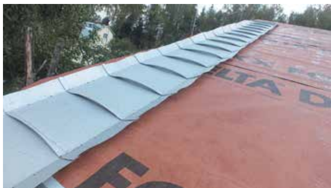
Монтаж первого ряда фальцевых картин вдоль фронтонного свеса крыши (бельгийский вариант)
