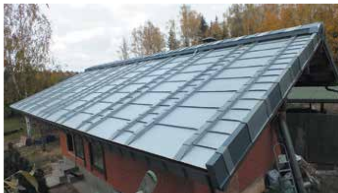
Угловой фронтонный элемент в зоне карниза
