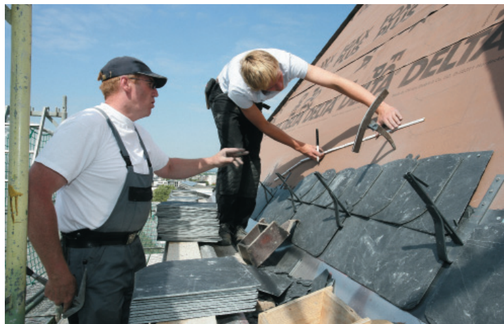
Кровельщик Геберт Беккер показывает ученику Роману Бассингу, как должна быть расположена каждая плитка
