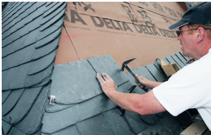
Монтаж сланцевой плитки на хребтах
