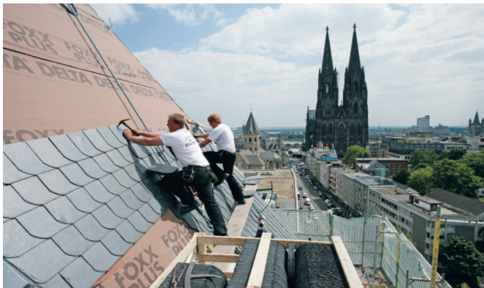
Работа по скату на высоте 36 м на фоне Кельнского собора (слева направо: подмастерье – Андре Гросс, кровельщик – Себастьян Шульц)
