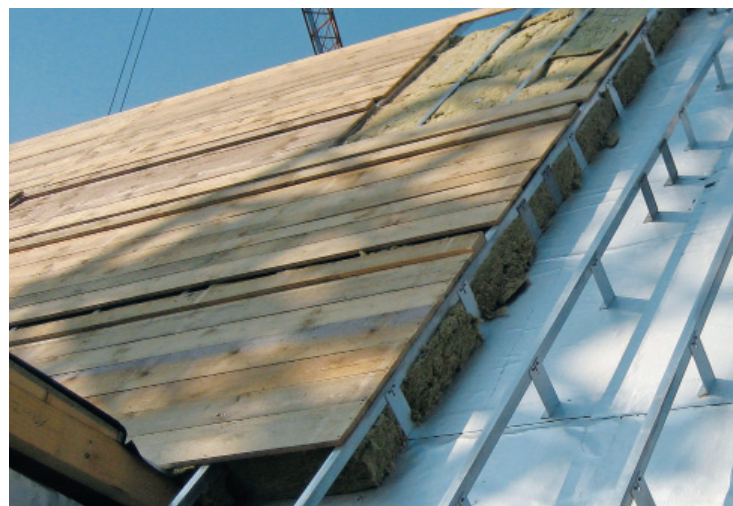
Кровельный «пирог» в процессе строительства
