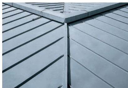
Гребень с брусом и профилем покрытия
