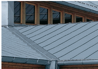
Ендова с простым и дополнительным фальцем
