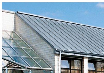
Конек односкатной кровли с брусом кровли
