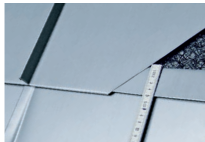
Поперечный шов, как простой фальц
