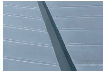
Внутренний желоб с вклеенным страховочным желобом
