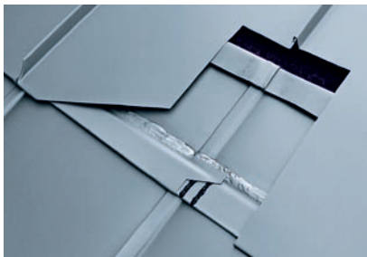
Оптимизация узла: дополнительная планка
