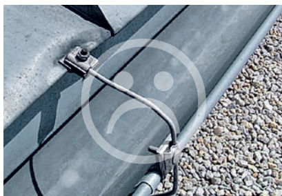
Blitzschutz Fixierung der Schar am Traufpunkt = Dehnungsrisse an Schare
