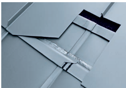
Detailoptimierung: Zusatzhaftstreifen
