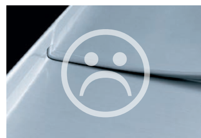
Pulldachfirst ohne Bewegungsbereich und zu geringer Aufstellhöhe
