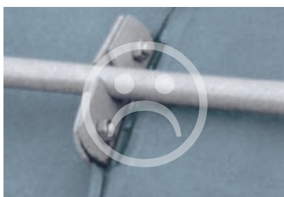
Schneefangsystem Die Klemme muss die thermische Dehnung des Rohres aufnehmen.
