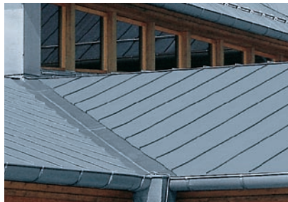
Kehle mit Einfach- und Zusatzfalz
