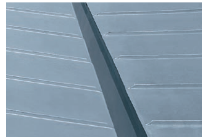
Innenliegende Kastenrinne mit ausgeklebter Sicherheitsrinne
