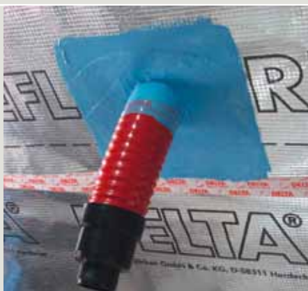
Уплотнение проходки DELTA®-LIQUIXX
