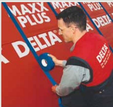
Уплотнение контробрешётки DELTA®-SB 60
