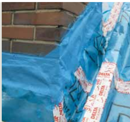
Примыкание к трубе DELTA®-LIQUIXX
