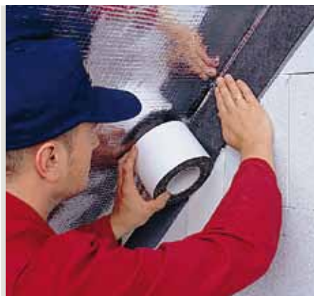
Примыкание к стене DELTA®-FLEXX BAND
